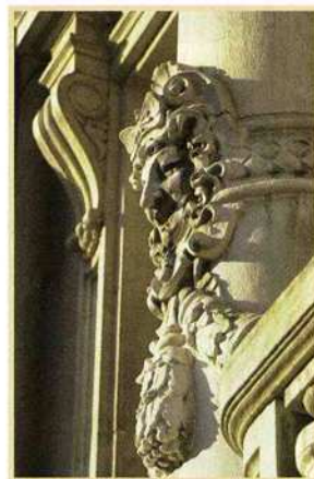
Détail de la façade.
