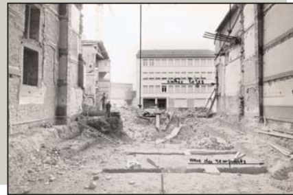
Photographies de la rénovation de 1962 à 1964. (archives municipales de Bourg-en-Bresse 300 W 4).
